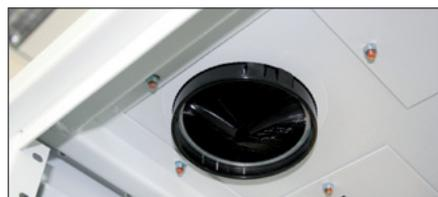
Exemple de plateaux et de passe-câbles installés dans une baie
