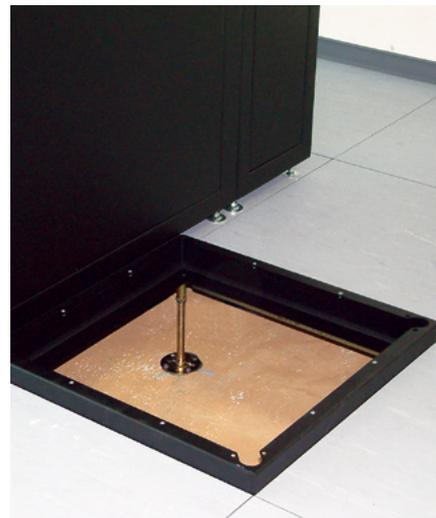
*Un cadre soudé remplace la dalle de plancher et permet le positionnement correct de la baie sur le faux plancher.*
