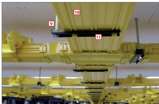
2. Exemple d'installation d'OptiWay au plafond
