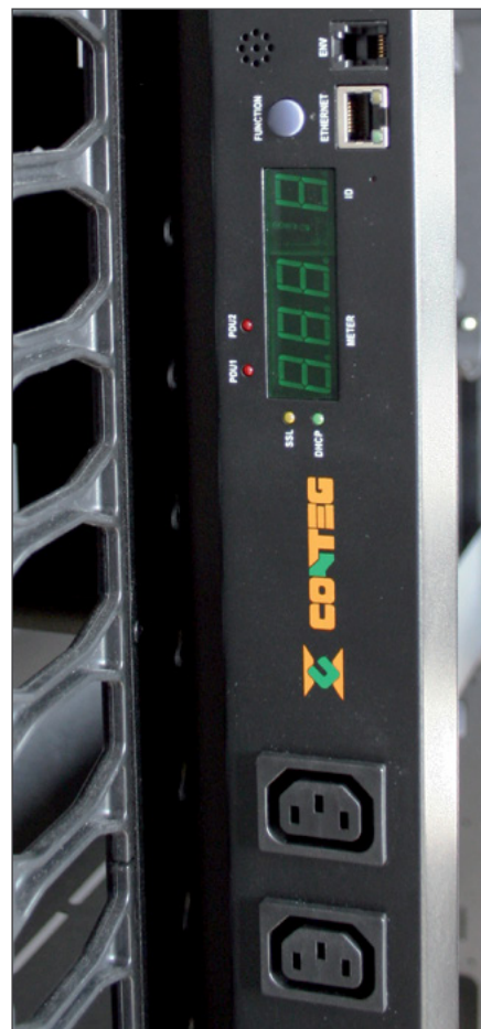
Блок распределения электропитания с возможностью мониторинга
